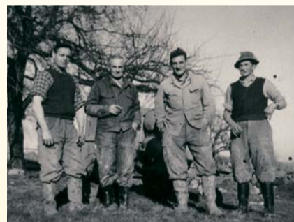
Wasserleitungsbau in Rüenberg: Arnold Flüeler, Brunnenmeister; Grabarbeiter Arnold Ruepp, Heini Schaffner und Hans Ruepp
